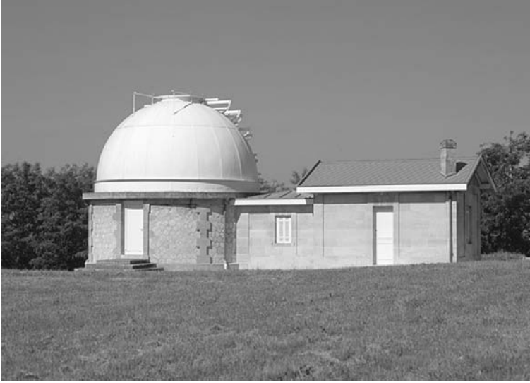
Figure 9.2. Vue actuelle du bâtiment de l'équatorial photographique de l'observatoire de Bordeaux : coupole avec son entrée à gauche, au centre le laboratoire photographique et à droite la salle destinées aux mesures des plaques.
