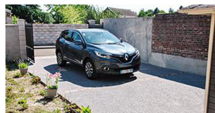
➡ Une allée en béton drainant.
