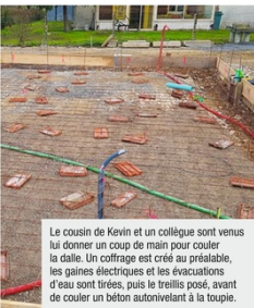
La dalle est d'une épaisseur qui varie de 13 à et 16 cm par endroit. Suffisant pour assurer la stabilité de la structure du garage. Elle sera recouverte d'un produit de cure pour éviter les fissures.
