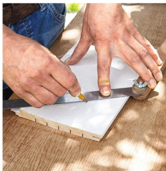
11 Reportez l'angle sur les lames de lambris. Réglez la scie radiale et coupez.
