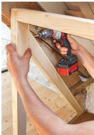
9 Pour finaliser la structure à gauche, un tasseau latéral ferme le côté afin de pouvoir y fixer les lambris.
