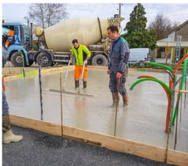
La dalle est d'une épaisseur qui varie de 13 à et 16 cm par endroit. Suffisant pour assurer la stabilité de la structure du garage. Elle sera recouverte d'un produit de cure pour éviter les fissures.
