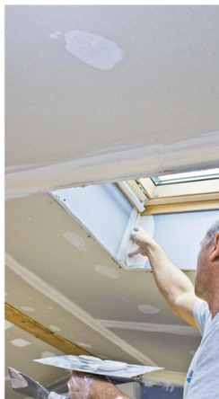
28 Enduisez les têtes des vis. Consolidez les angles rentrants et les arêtes saillantes en noyant entre deux couches d'enduit une bande d'armature pliée en L. À chaque fois, lissez soigneusement.
