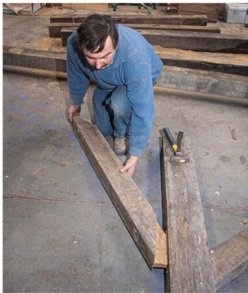
7 Réalisez un prémontage au sol, à l'aplomb de l'épure, afin de vérifier la pénétration des assemblages à tenon et mortaise et les dimensions générales des pièces.
