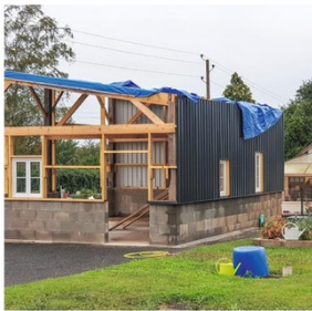
Kevin se rend compte après coup que des projections dues aux découpes à la meuleuse, réalisées par le charpentier, ont endommagé les menuiseries et le bardage en tôle.
