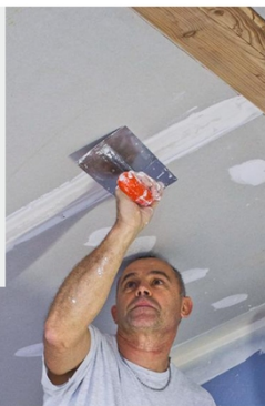
27 Préparez l'enduit à joints. Appliquez-en au couteau une première passe dans le creux formé par les bords amincis. Déroulez rapidement une bande de calicot, en la centrant bien, et serrez-la en éliminant l'excédent avec la lame inclinée. Laissez sécher et refaites une passe à l'aide d'un outil plus large, comme un plâtre.
