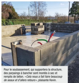
La dalle est d'une épaisseur qui varie de 13 à et 16 cm par endroit. Suffisant pour assurer la stabilité de la structure du garage. Elle sera recouverte d'un produit de cure pour éviter les fissures.
