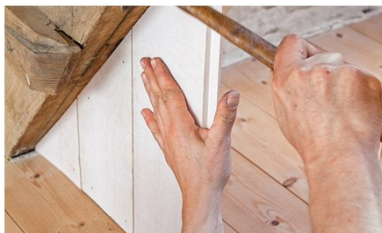
12 Posez les lames en les emboîtant puis en les clouant sur les tasseaux. Pour vos découpes, prenez en compte le décalage induit par l'emboîtement des languettes dans les rainures des lames.
