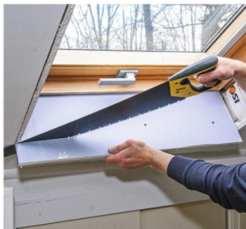
26 Les bandes d'habillage dépassent en largeur de 4 ou 5 cm. Elles sont fixées et arasées au fur et à mesure à la scie égoïne. Si besoin, les coupes seront égalisées au rabot surfum.
