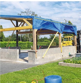
La connexion entre la charpente et les parpaings est assurée par des équerres en fer plat. Mise en œuvre par un charpentier, la structure bois a posé quelques soucis à Kevin.
