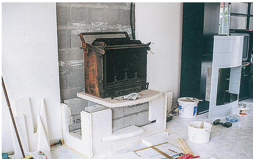
5 Doublez le socle avec des carreaux de plâtre. Coiffez-le de la dalle foyer et placez le foyer dessus, pour avoir suffisamment d'espace derrière pour l'isolant et laisser circuler l'air chauffé dans la hotte.
