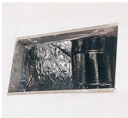
9 Découpez également, dans les joues de la hotte et leur doublage, les ouvertures de 20 x 40 cm qui servent à diffuser l'air chaud dans la pièce. Posez ensuite les grilles métalliques.
