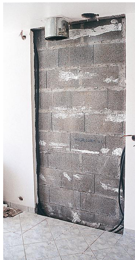
1 Le doublage isolant est découpé à l'emplacement choisi pour la cheminée. Si des gaines électriques passent à cet endroit, il faut les dévier.
