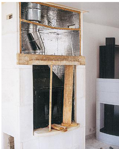
8 Aménagez la chambre de décompression en partie haute, sans oublier les ouvertures latérales permettant sa ventilation. Doublez comme précédemment.
