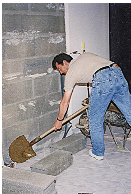
3 Réalisez le socle avec des parpaings de 15 cm disposés à plat et scellés au mortier standard. Montez à l'arrière et à l'avant, deux cloisonnettes de 10 cm d'épaisseur.
