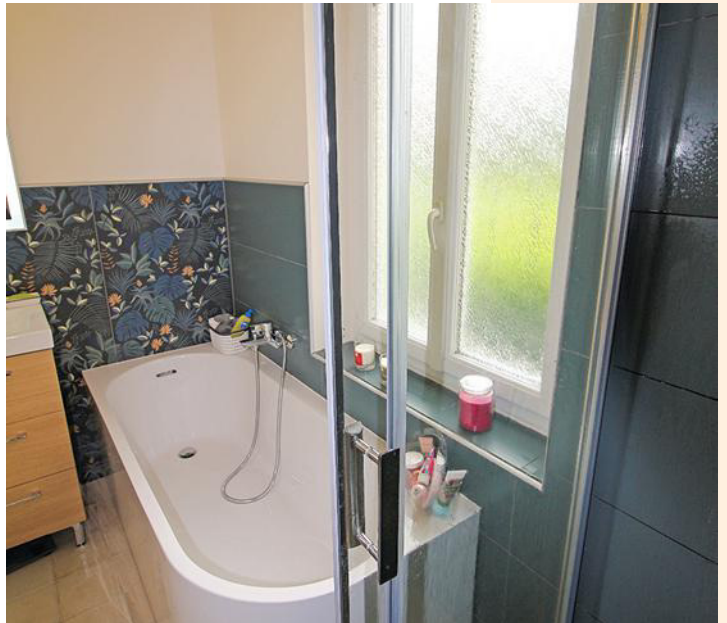
Dans la salle de bains, les lignes de jonction de la baignoire avec les murs sont jointées au mastic silicone. Idem pour la vasque située à côté.
