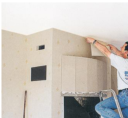
10 Vous pouvez maintenant commencer à habiller la façade du coffrage. Ici, en parties haute et basse, avec des plaquettes de parement en pierre reconstituée posées au mortier colle.
