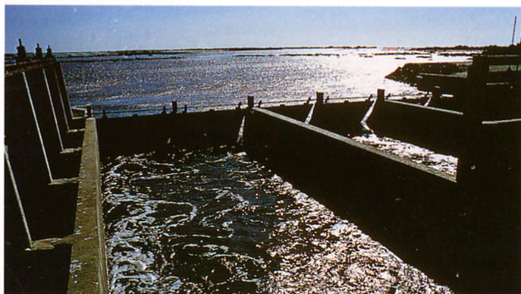
Ci-contre : PRISE D'EAU À LA MER. REFOULEMENT DANS LE PREMIER PARTÈNEMENT. AIGUES-MORTES
