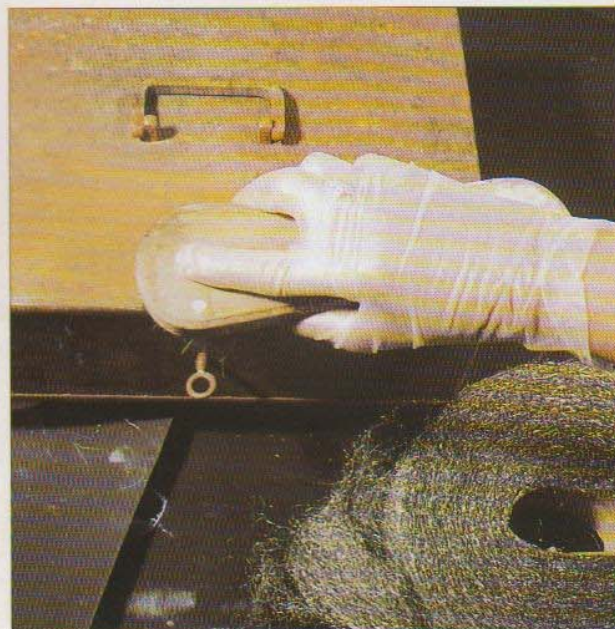
Décapage à la brosse ou au tampon
