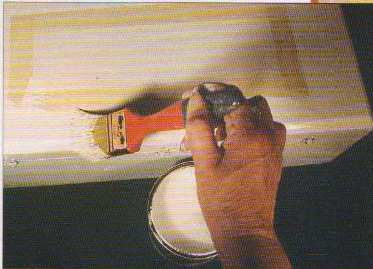
Pose de la peinture de base au pinceau
