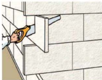
Découpe et ajustement des panneaux
