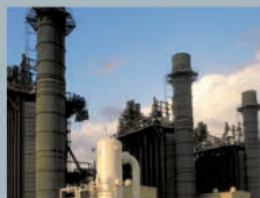
L'extraction du gaz
