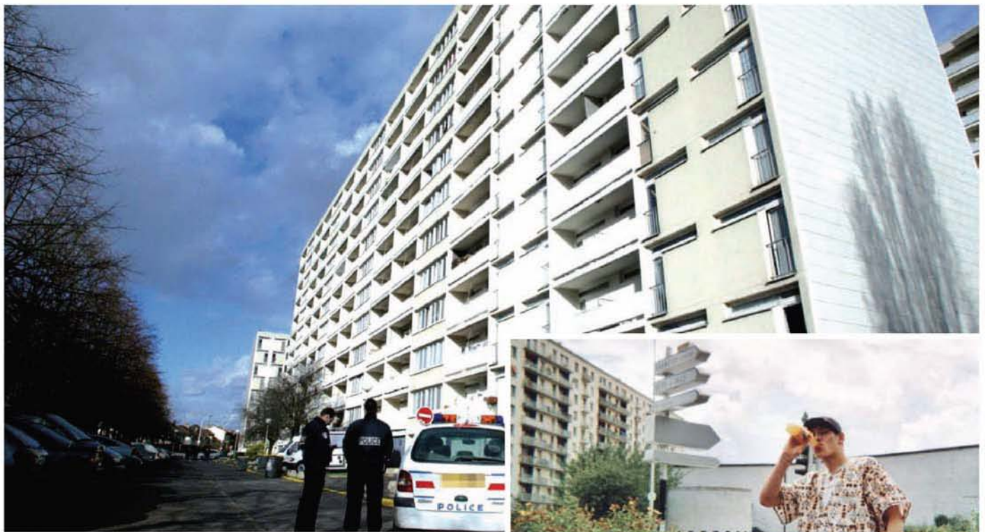
Un appartement vide de la tour Prokoviev fait office de lieu de détention avant que Fofana ne transfère Ilan dans une chaufferie de l'immeuble. Jérôme Ribeiro (à droite) sera le premier de ses gardiens à craquer et à quitter le gang des barbares.
