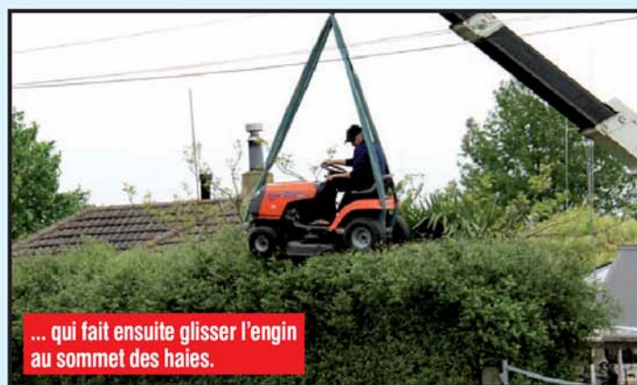
Le tracteur tondeuse est soulevé par une grue...
