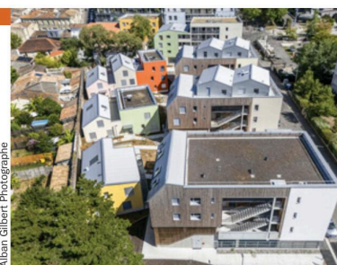
Cité Paul Boncour, à Bordeaux. Logements traversants, isolation... La priorité est donnée au confort thermique à l'année.
