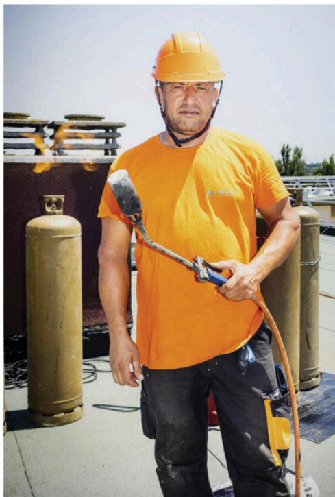
Abderrahim Jouji, à Arles, le 9 juillet. Étancheur, il travaille toujours avec un chalumeau sur des toits exposés au soleil.
