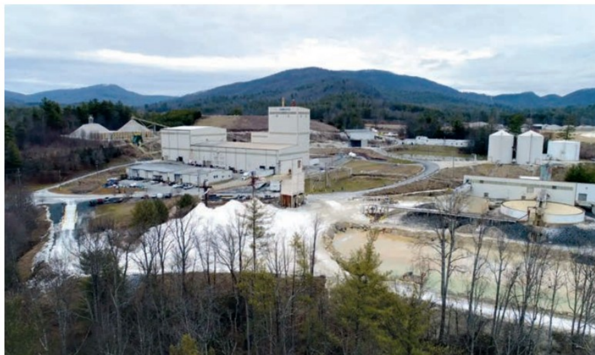
L'industrie mondiale du semi-conducteur commence ici, dans une mine perdue au milieu des pins et des sapins. (Photo : Sibelco)
