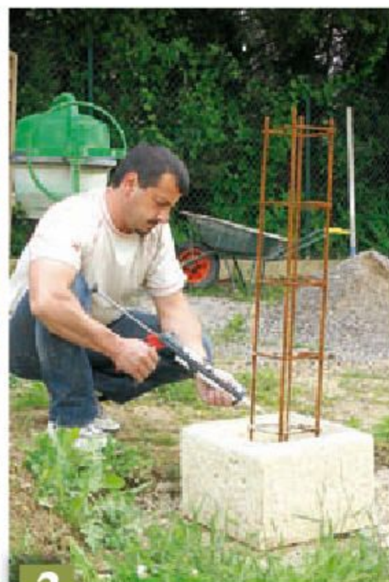
3 Éventuellement, déposez un cordon de joint pour éviter les coulures de laitance de ciment entre les éléments de pilier.
