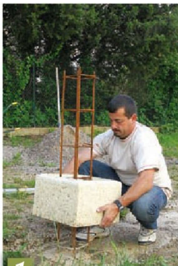
1 Posez le premier module sur l'assise.
