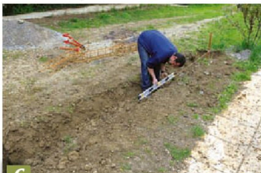
4 Tracez la fouille avec de la peinture de marquage en aérosol ou avec du plâtre.
