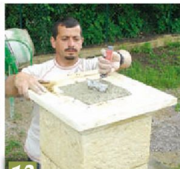
13 Posez le chapeau. Il peut être scellé au ciment ou collé avec un mastic-colle pour maçonnerie.
