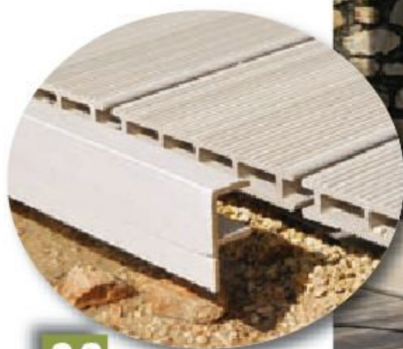
23 Emboîtez la gorge du profilé de finition sur le chant des lames.
