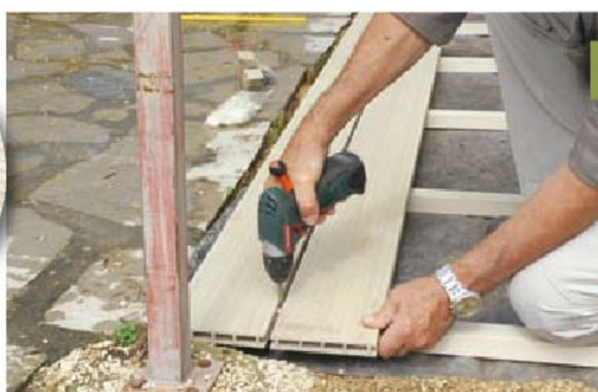
14 Utilisez la chute de la coupe pour entamer la seconde rangée.
