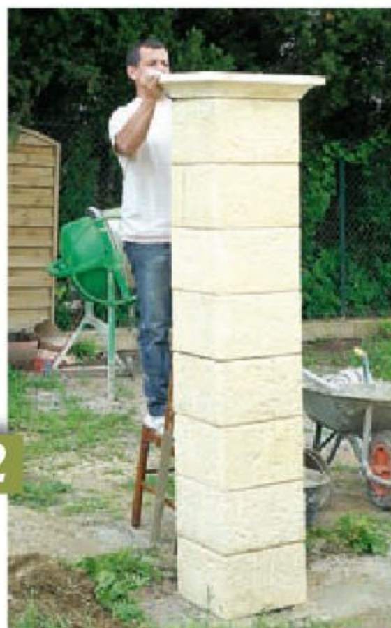
13 Posez le chapeau. Il peut être scellé au ciment ou collé avec un mastic-colle pour maçonnerie.
