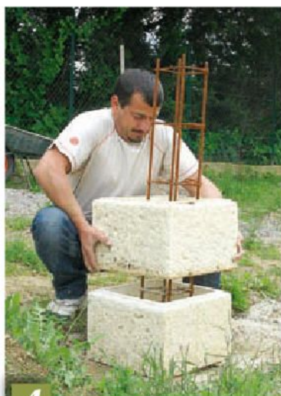
4 Emboîtez les modules les uns sur les autres.
