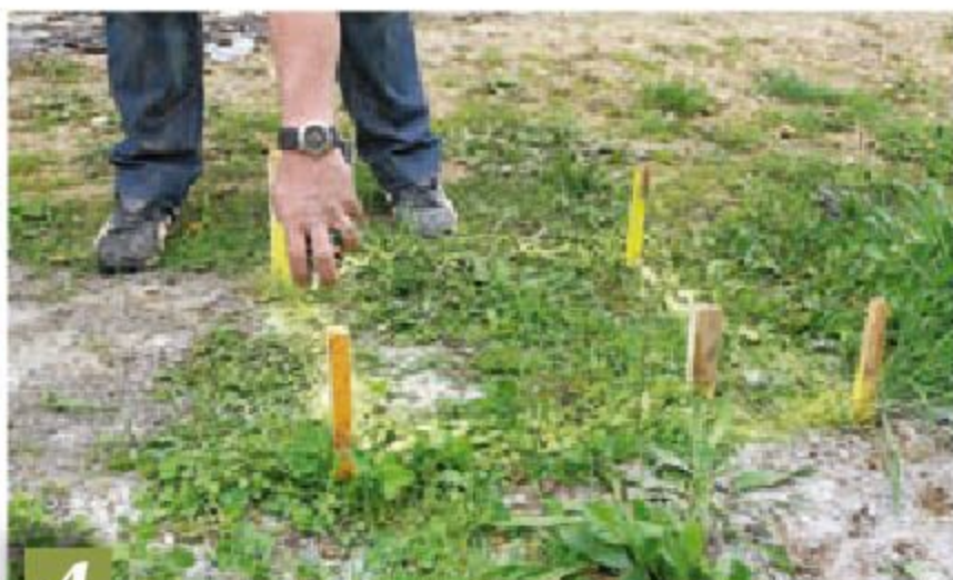
4 Tracez la fouille avec de la peinture de marquage en aérosol ou avec du plâtre.
