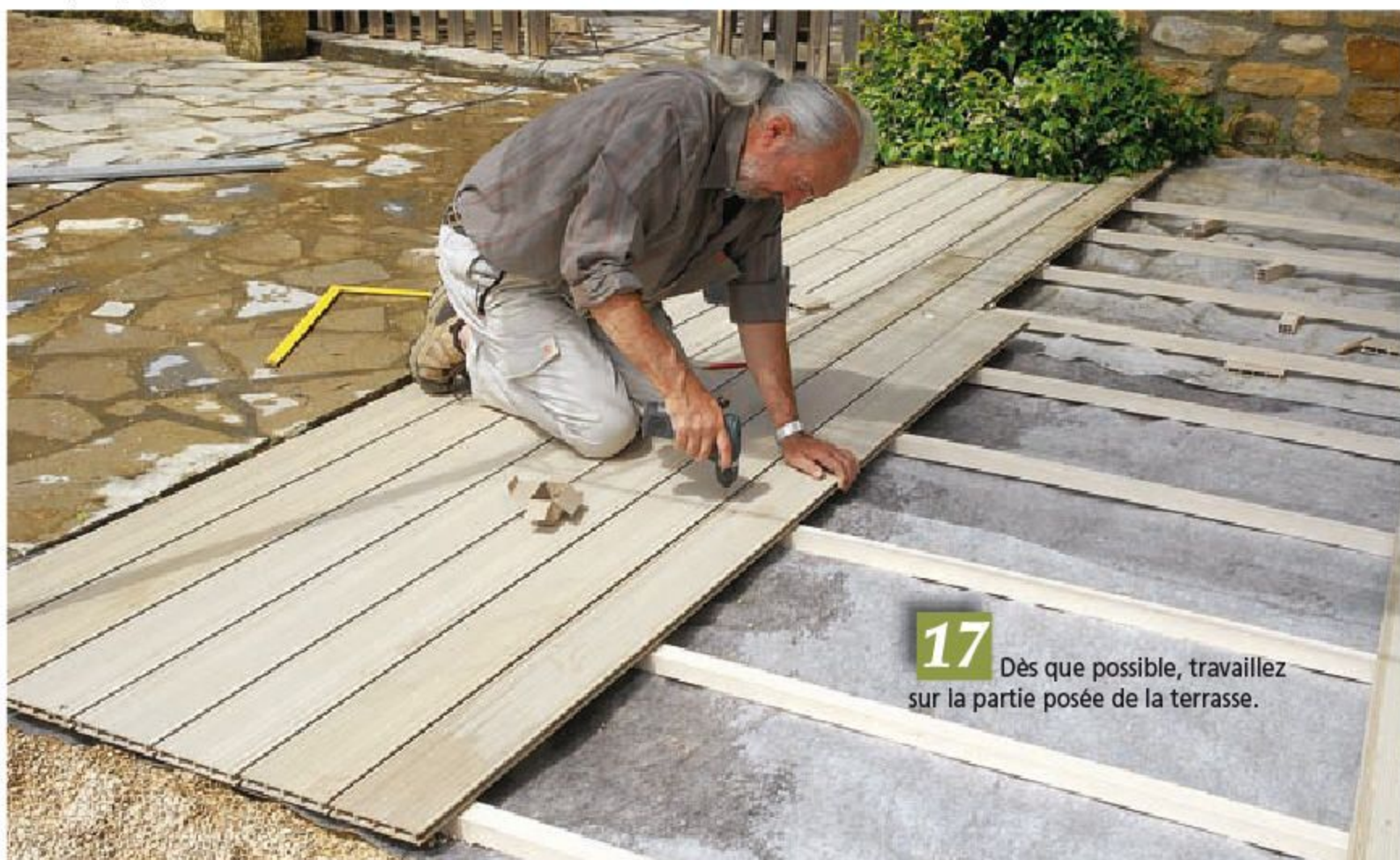
15 Emboîtez la lame dans les clips déjà posés.
