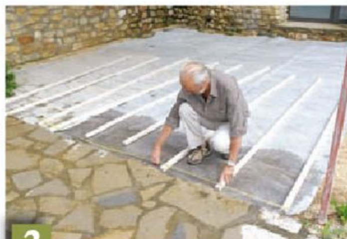
1 Sur un sol en terre, étalez un feutre géotextile ( Bidim ) pour empêcher la pousse des mauvaises herbes.
