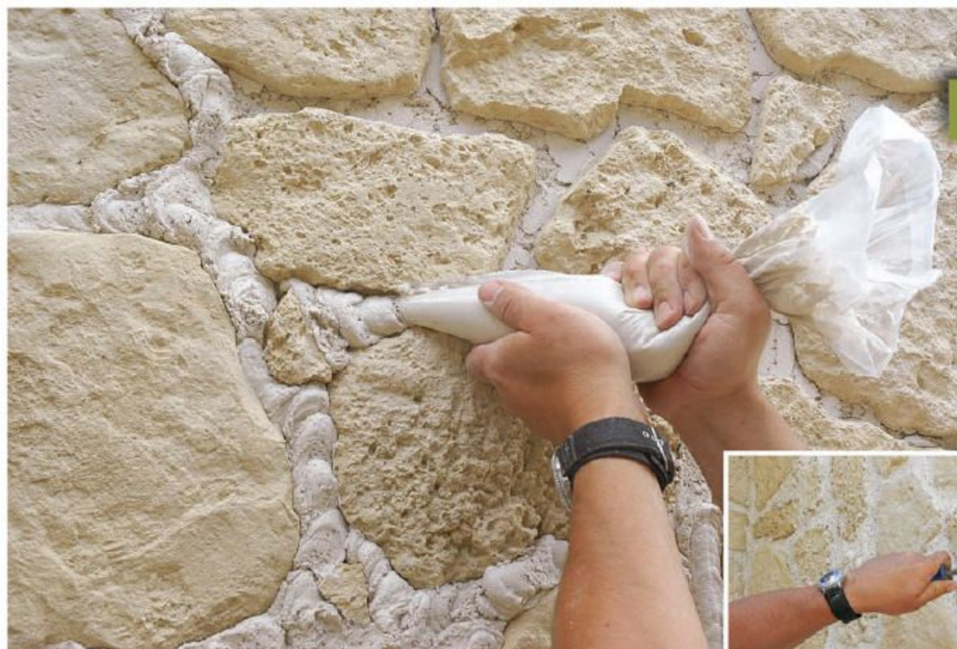
3 Remplissez la poche avec le mortier à joint préparé.
