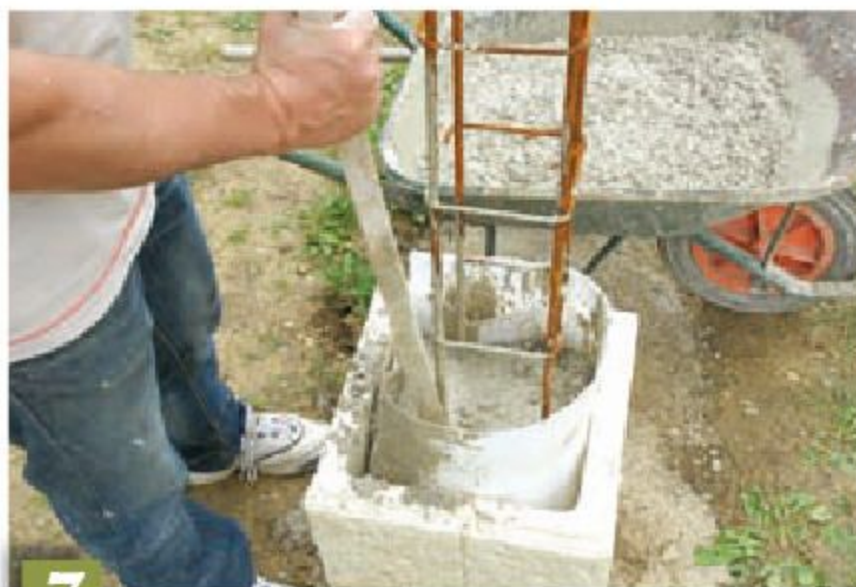
7 Tassez le béton avec un bâton.
