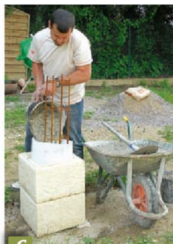
6 Coulez le béton au seau en veillant à ne pas salir l'extérieur du pilier.
