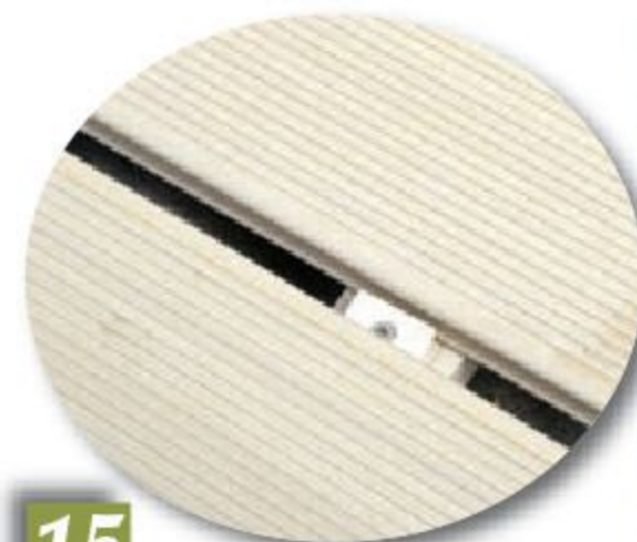
13 À la jonction de deux lames, glissez un morceau de lambourde et posez un clip à cheval sur les deux lames.
