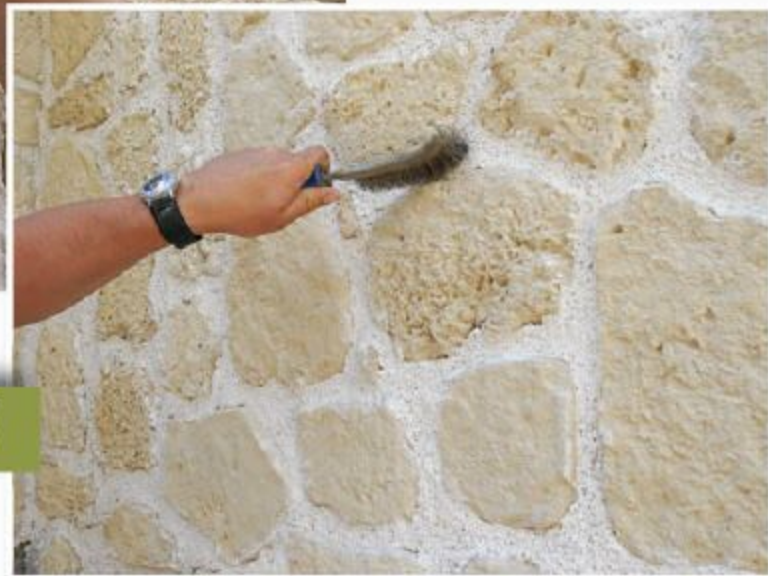
5 Lorsque le joint a pris et, avant qu'il ne soit trop sec, grattez à la brosse métallique puis à la brosse de chiendent pour obtenir des joints réguliers.
