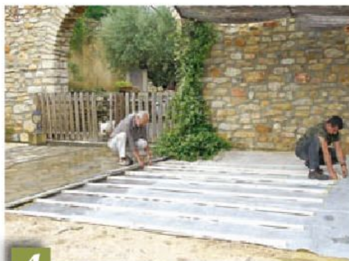
2 Superposez les bandes de feutre de 20 cm.
