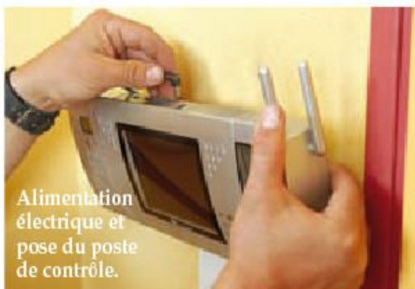
Raccordement des fils au poste de contrôle : les 4 fils de la platine de rue, les 4 fils de la caméra extérieure et 2 fils pour la commande d'automatisation du portail.
