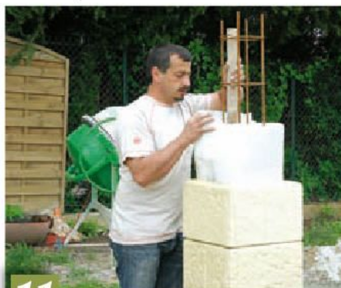
11 Poursuivez l'empilage des modules et leur remplissage.
