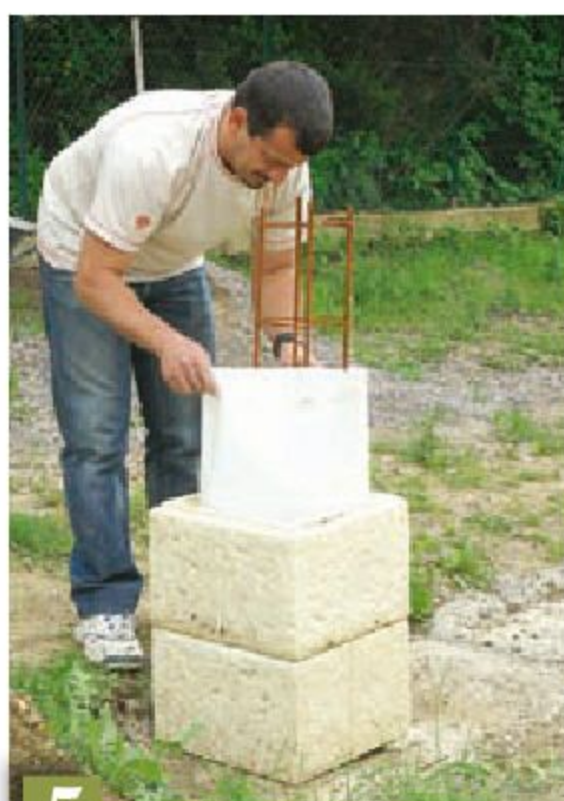
5 Disposez contre les parois intérieures du pilier, un morceau de feuille de mousse de polyéthylène de 2 mm d'épaisseur (utilisée couramment en sous-couche de parquet flottant).
