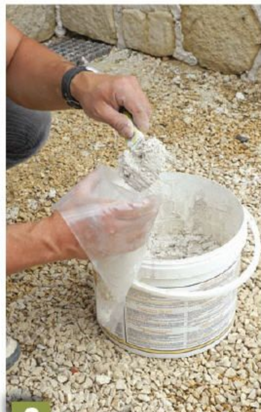
3 Remplissez la poche avec le mortier à joint préparé.
