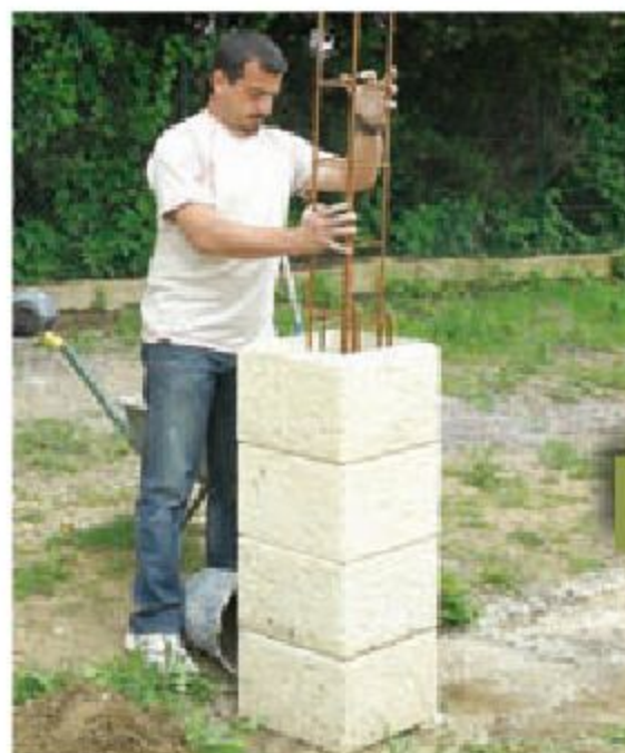
8 Après avoir rempli trois éléments, emboîtez le quatrième et posez le ferrailage complémentaire.
