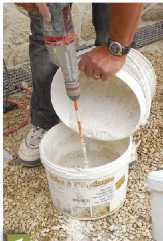
1 Préparez le joint en mélangeant la poudre avec de l'eau au malaxeur.
