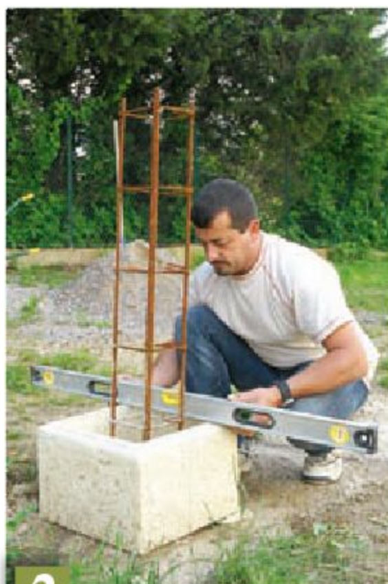
2 Vérifiez son horizontalité dans les deux axes, calez, au besoin.
