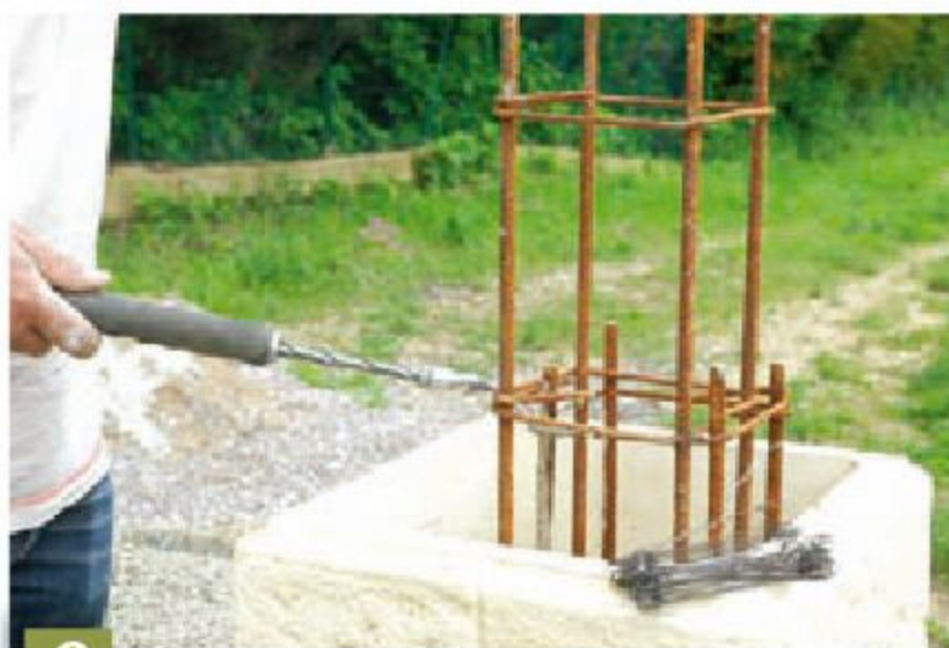
9 Liez les ferrillages entre eux avec du fil de fer et des tenailles ou avec des liens à boucles galva et un lieur automatique.
