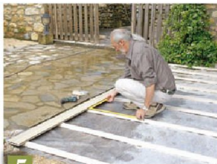
3 Posez les lambourdes avec un espacement de 40 cm entre axes.
