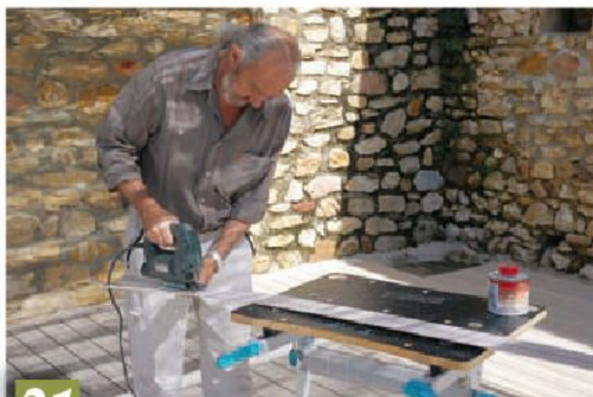
21 Découpez le profil de finition à la bonne hauteur à la scie sauteuse ou au cutter.
