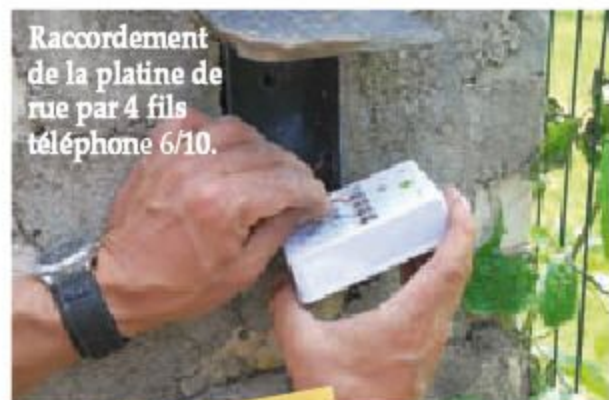
Raccordement des fils au poste de contrôle : les 4 fils de la platine de rue, les 4 fils de la caméra extérieure et 2 fils pour la commande d'automatisation du portail.
