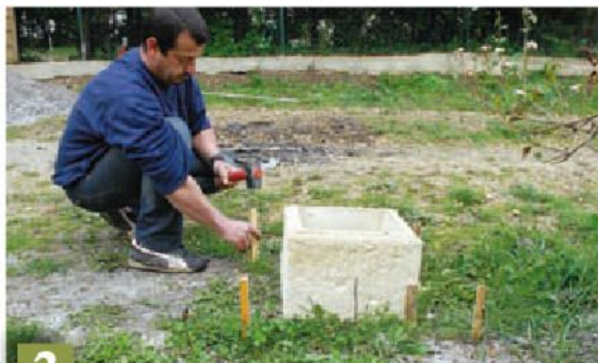
3 Repérez avec des piquets le contour de la fouille.
