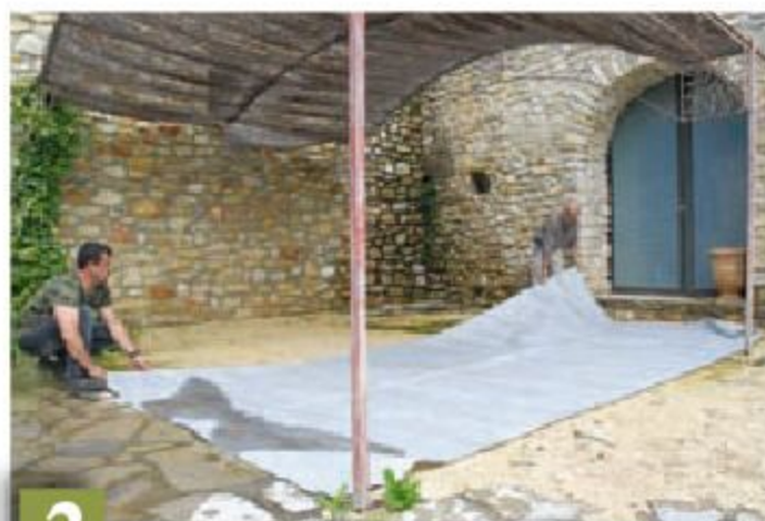
1 Sur un sol en terre, étalez un feutre géotextile ( Bidim ) pour empêcher la pousse des mauvaises herbes.
