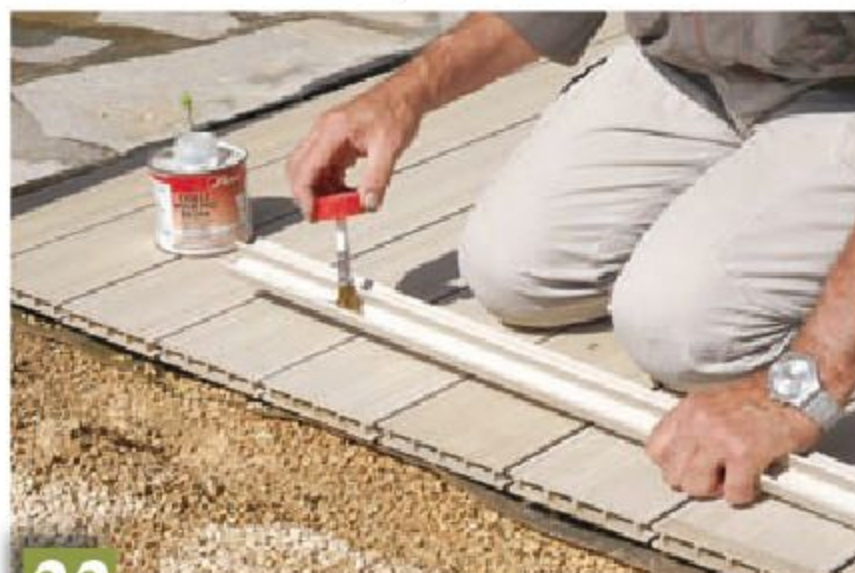
22 Encollez le profilé de finition avec de la colle pour PVC.
